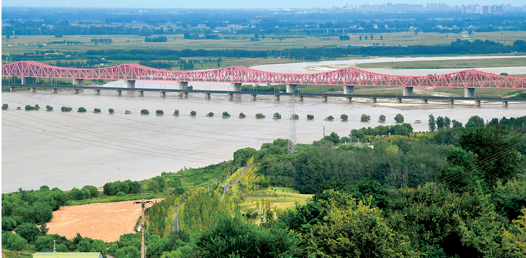
黄河铁路大桥
