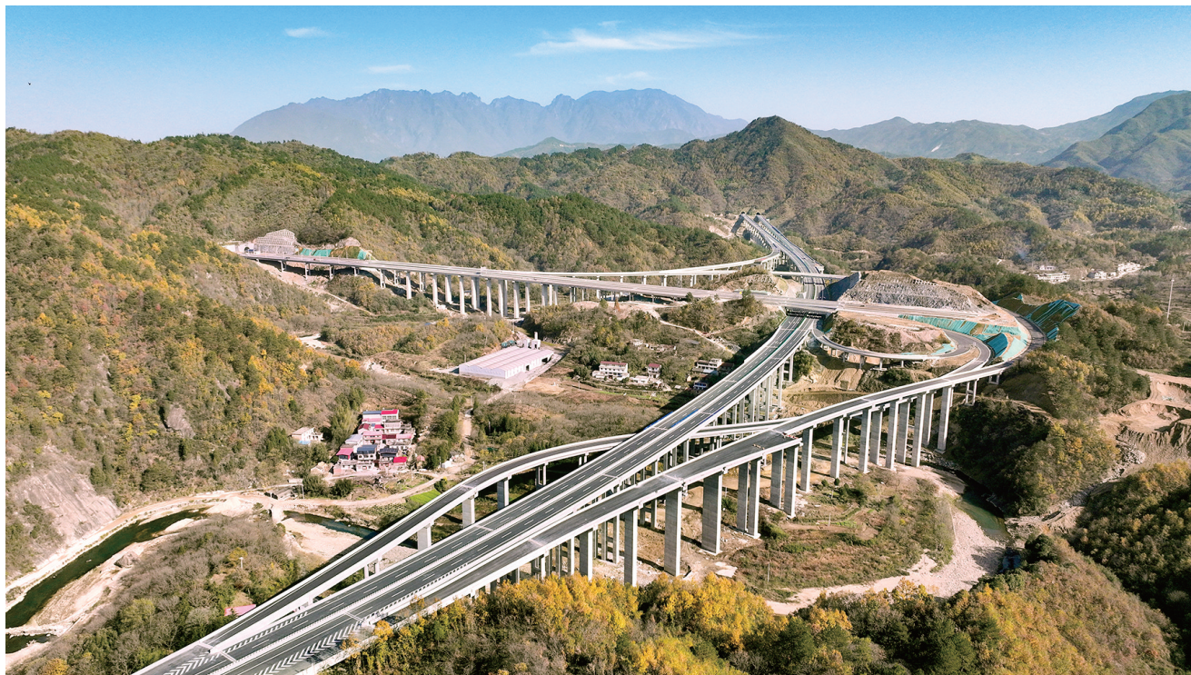
我省加快推动高速公路建设(图为在建的阳新高速豫鄂界一期廖家湾枢纽工程)
