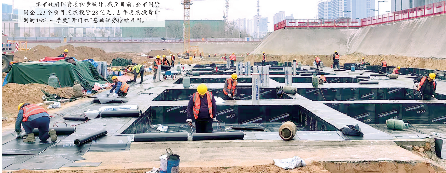
高新生物经济产业园项目工地现场，工人们热火朝天赶工忙 受访者供图
