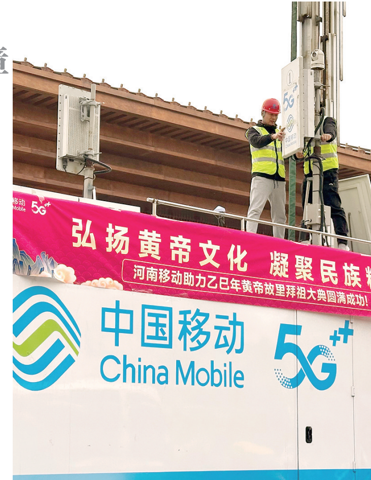
调测开通应急通信车网络信号
