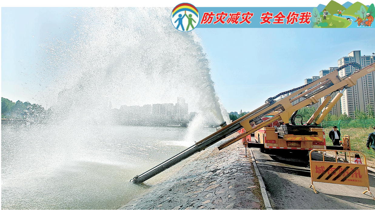
防汛应急演练现场
