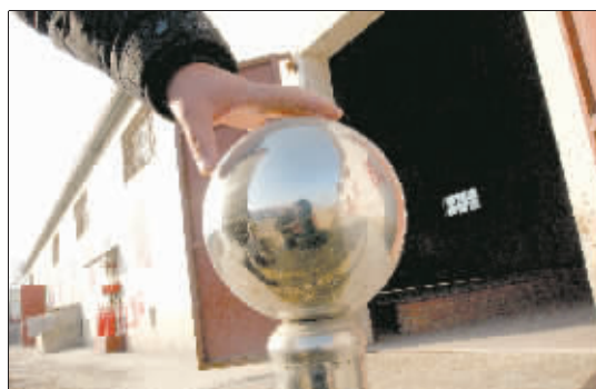
仓库的每个大门口都有这样一个不锈钢球柱子，工作人员进入仓库前都要先摸一下，释放出身上的静电。
