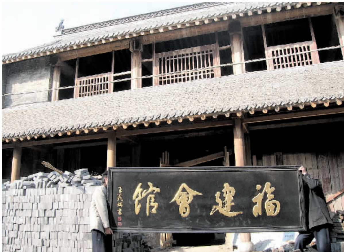
恢复工程已接近尾声的福建会馆
