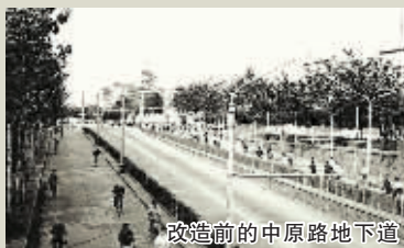
改造前的中原路地下道
