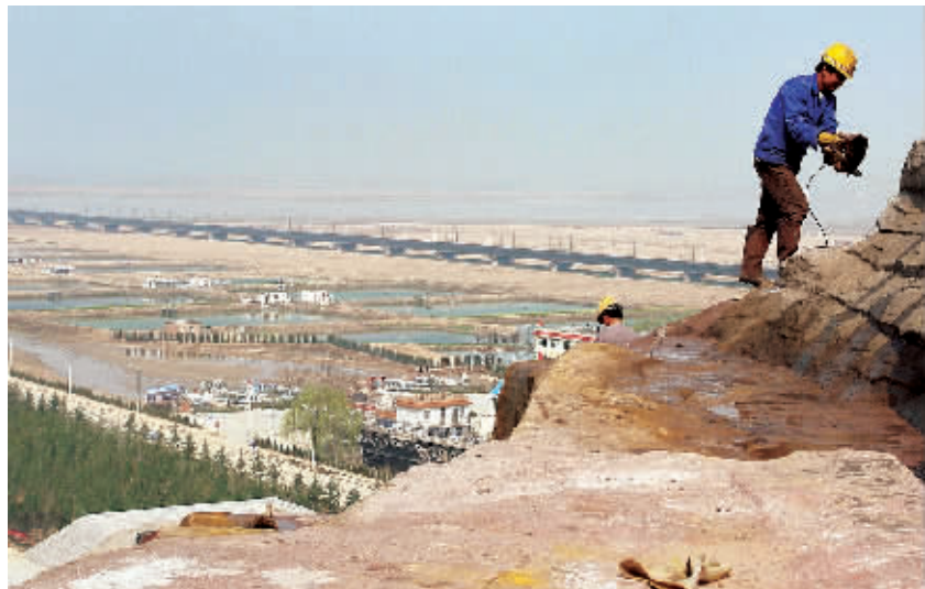
建筑工人在塑像下的山坡上做最后的扫尾工程,工人背后就是滔滔的黄河。
