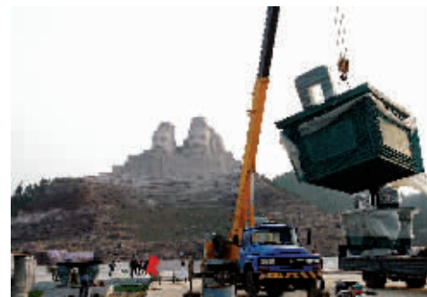
工人们正在安装刚刚运抵郑州的大鼎。
