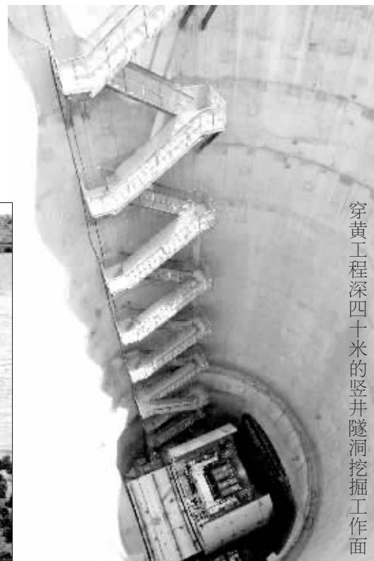
穿黄工程深四十米的竖井隧洞挖掘工作面
