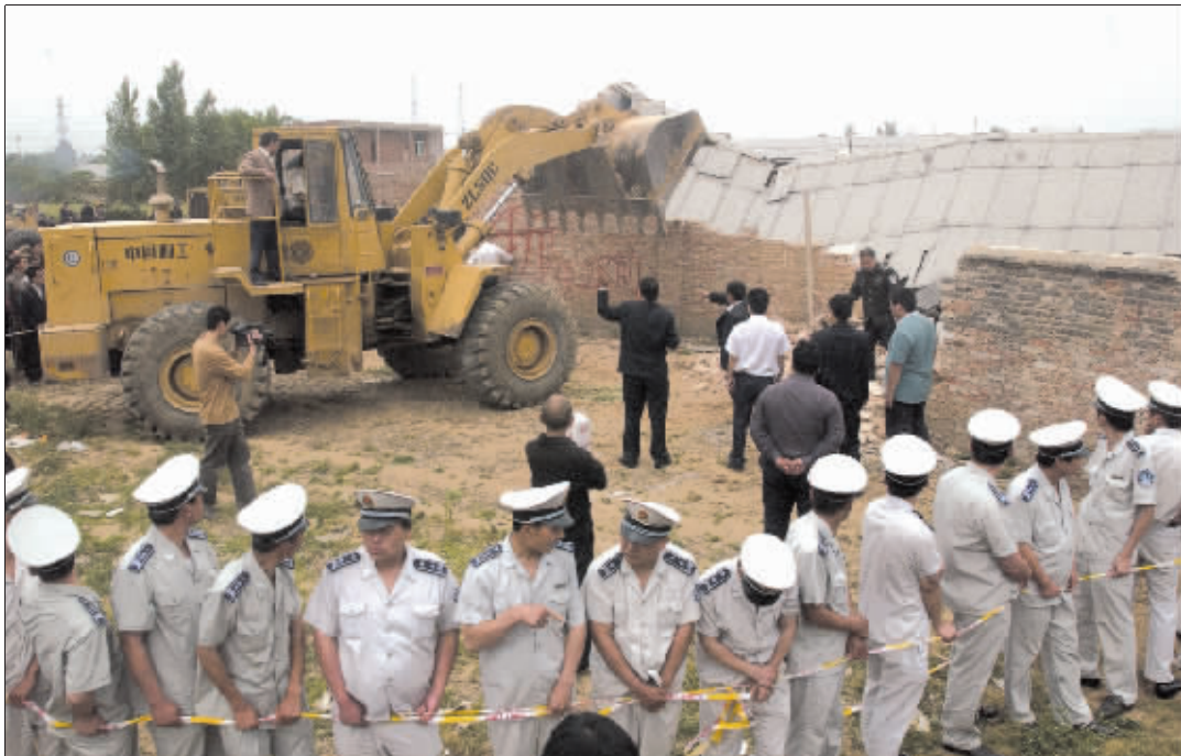
500多名执法人员强制拆除违法建筑
