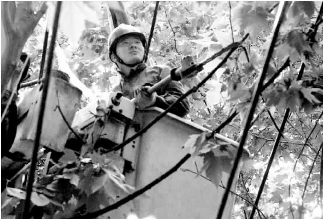
昨日下午,为了防止险情再次发生,工人正在高空修剪掉紧挨着高压线的树枝。 晚报记者 周甬 图
