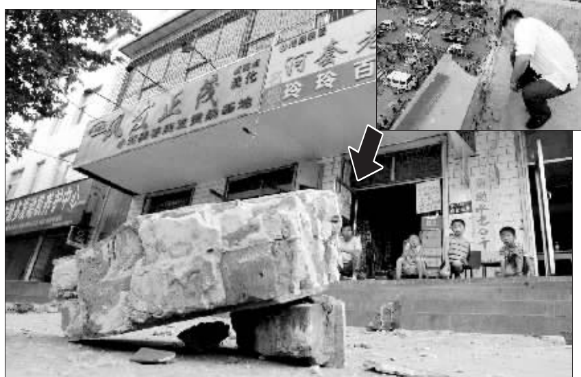
楼顶的一个墙角被炸飞,坠落到大街上
