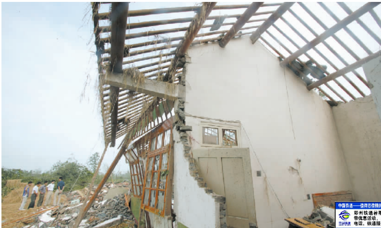
7月4日在安徽天长拍摄的遭龙卷风袭击损毁的房屋。 新华社发
