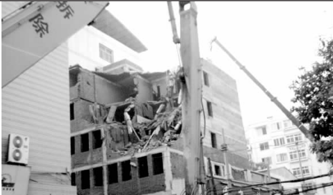
危楼正在拆除
