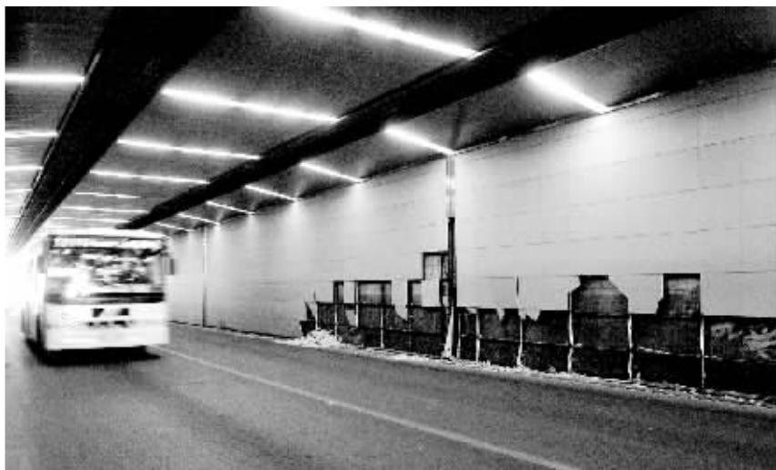
记者昨日在中原路地下道看到,刚修好不久的墙面上已经有瓷砖大面积脱落。原本漂亮的通道变得“伤痕累累”。希望相关部门对该处尽快修复,并提醒来往的司机朋友小心驾驶。
