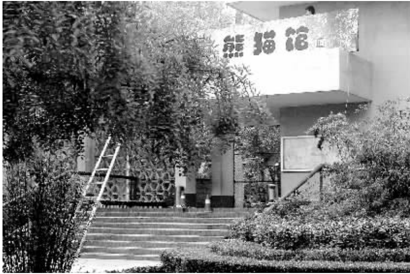
正在装修的熊猫馆
