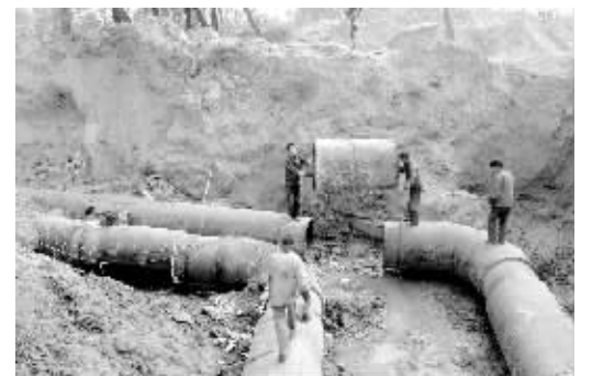
工作人员准备安装最后一根管道。
