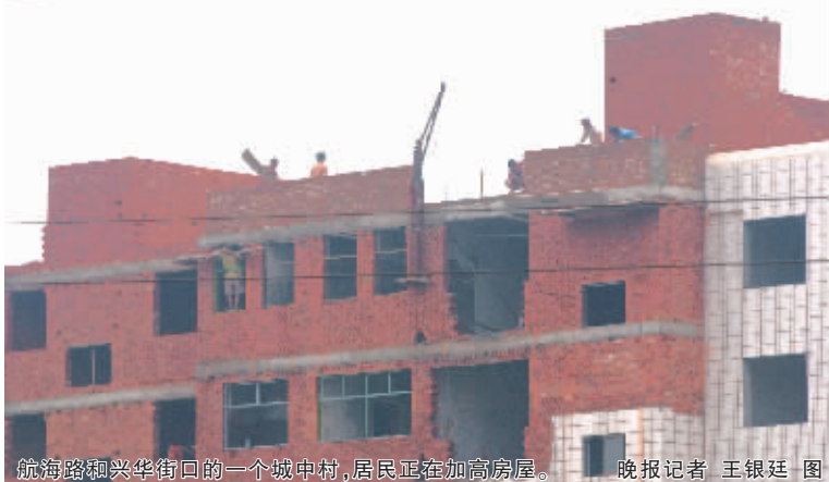
航海路和兴华街口的一个城中村,居民正在加高房屋。 晚报记者 王银廷 图
