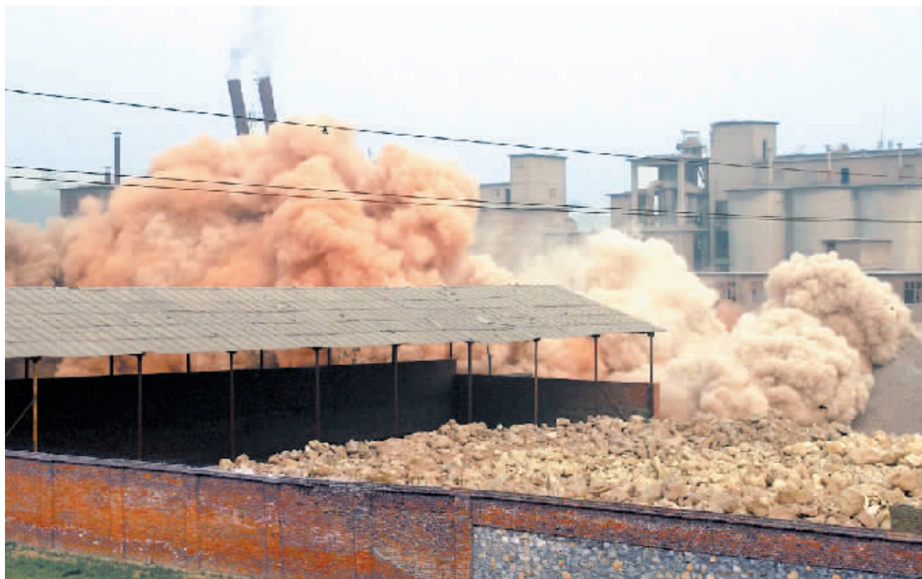
昨日上午 10 时, 巩义市米河镇华夏水泥厂内机械立窑水泥生产线被成功爆破, 拉响了郑州环境综合整治的“第一爆”。晚报记者 马健 图
