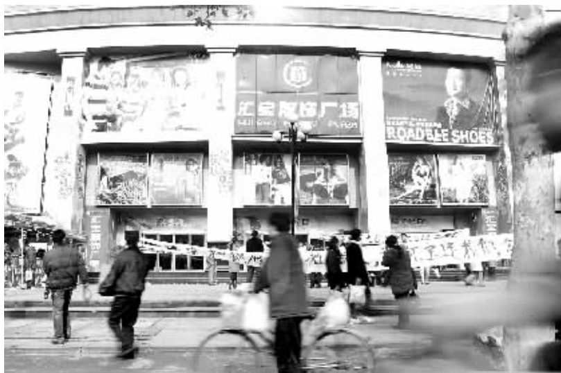
昨日上午,汇宝服饰广场的外墙上虽然仍满是服装广告,但大门已经紧锁停止了营业。 晚报记者 周雨 图
