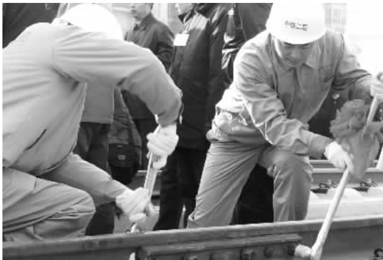
昨日,施工人员在铺设京津城际铁路最后一根铁轨。
