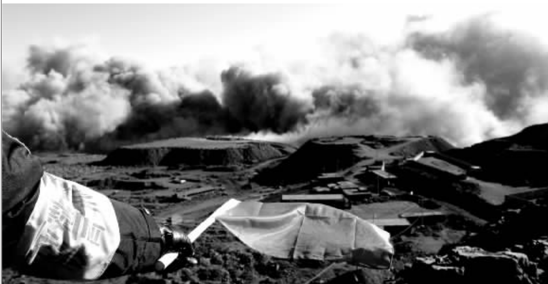
12月20日11时30分，随着5400吨炸药爆炸后一声沉闷的巨响，神华宁煤集团大峰煤矿羊齿采区的一座相对高度230米的山峰下沉约40米，近15年来我国最大的一次硐室爆破成功实施。实施此次爆破主要是为了能对羊齿采区的“太西煤”进行露天复采。改用露天复采后，矿井服务年限将延长15年，1400万吨“太西煤”将重见天日。“太西煤”在国际上被誉为“煤中之王”，是世界著名的优质无烟煤。 新华社发
