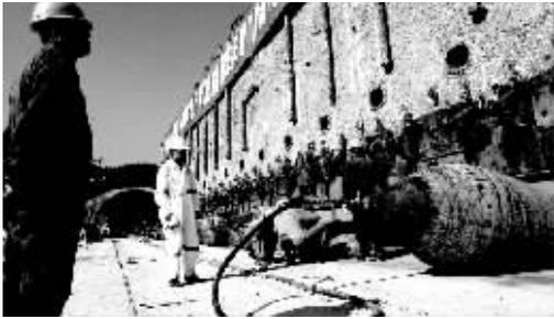
12月27日,几名工作人员在为铺设气囊充气。记者在现场看到,工程人员在“南海一号”沉箱与全潜驳“重任1601”的甲板之间铺设了16个气囊,16个气囊不断交替使用。27日11时左右,沉箱整体经过全潜驳与码头之间的钢板,顺利挪到码头上。经过10余个小时的拉移,“南海一号”沉箱已正式上岸,当日抵达新居“水晶宫”外。28日,“南海一号”将正式入住“水晶宫”。 新华社发
