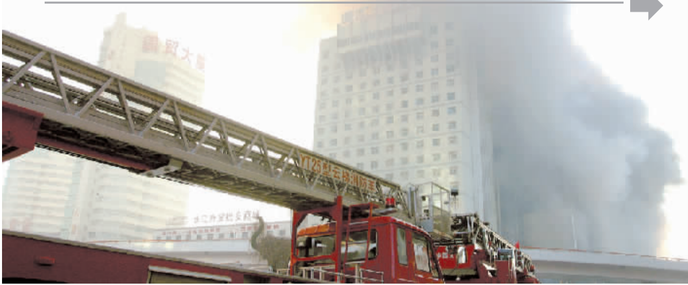
乌鲁木齐德汇国际广场大火现场。
