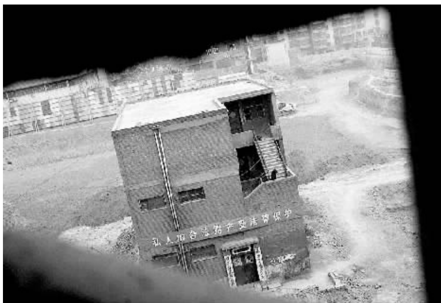
工地上孤零零矗立着三层小楼
