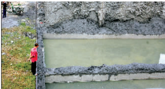
过滤池面积约40平方米，水深超过3米，四周堆满了煤渣。
