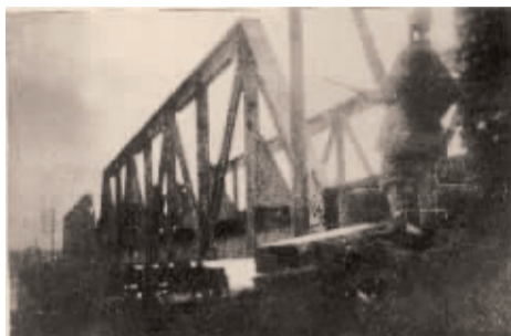
▲人民解放军占领郑州黄河铁路大桥
