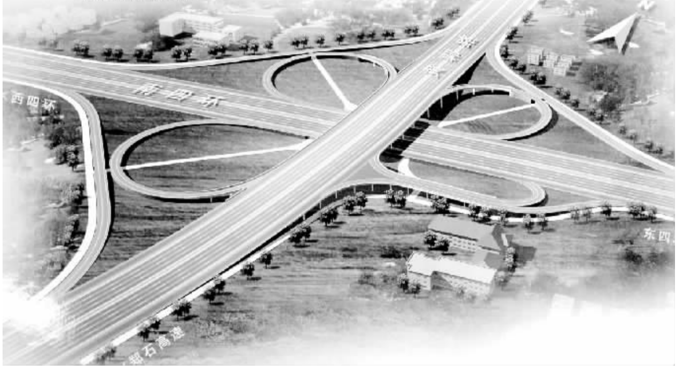
黄郭路南四环立交桥规划设计方案之苜蓿叶型互通立交
