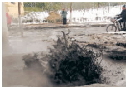
污水一直外喷，立交桥下变成一片黑泥潭。 晚报记者 廖谦 图
