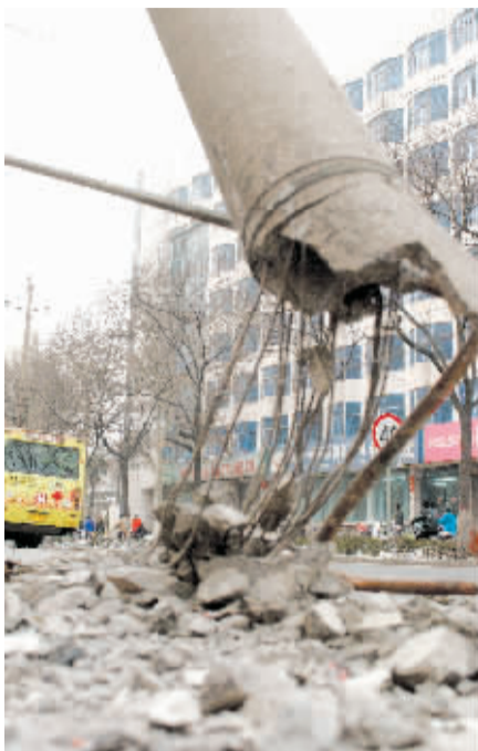
被撞断的电线杆靠底部仅剩的几根钢筋斜撑着。
