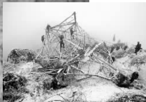
电力职工抢修线塔
