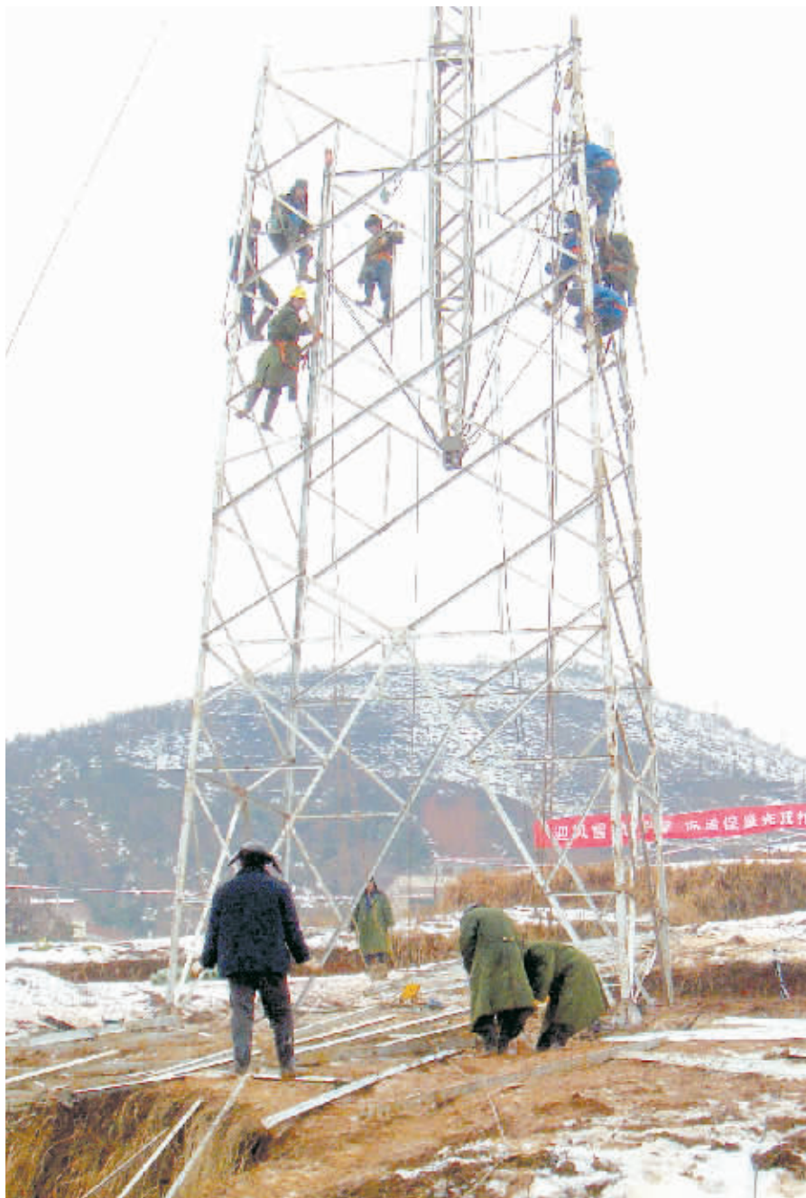
在深山里,在冰雪中,郑州电力工人夜以继日地抢修高压输电线路。 郑州供电公司供图
