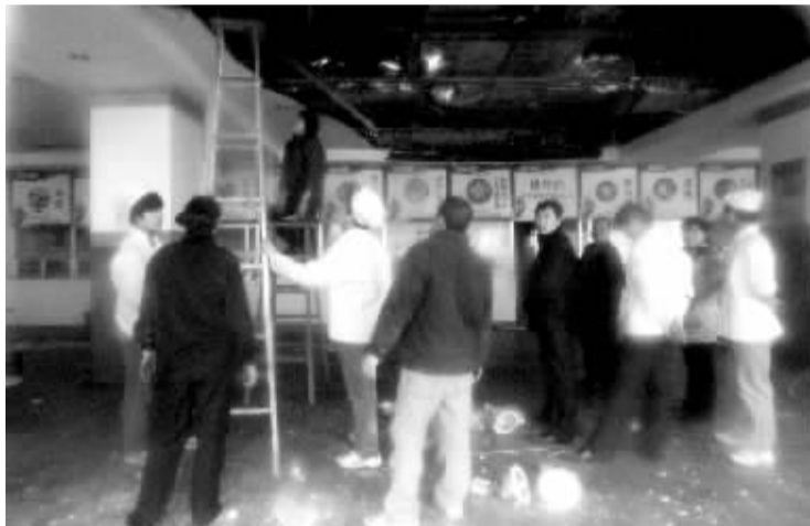
事发前,先是石灰块落入食客饭内,随后,近10平方米的吊顶就塌了。
