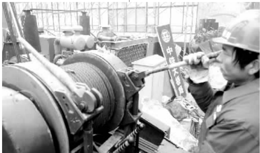
解放路立交桥施工现场
