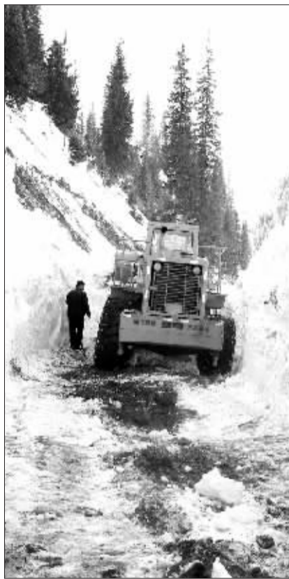
▲大型铲车正在清理雪崩堵塞的盘山道,被阻路段雪深3至5米。
