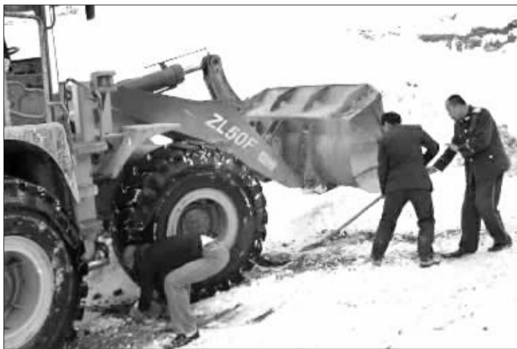
▲大型铲车正在清理雪崩堵塞的盘山道,被阻路段雪深3至5米。
