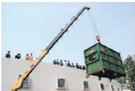
大吊车真厉害，轻轻一吊就起来，可我恐高，在这个大铁箱子里好怕怕啊。
