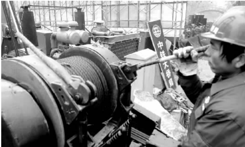
大项目之解放路立交桥开工 晚报记者 王梓 图
