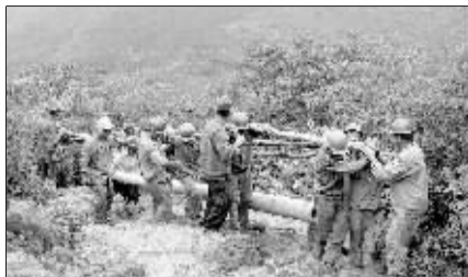
郑州供电公司开展新农村电气化建设
