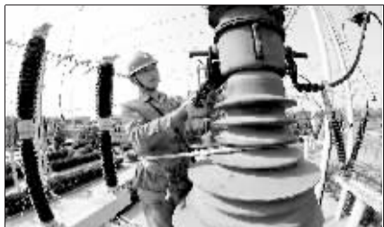
郑州供电公司开展迎峰度夏工程
