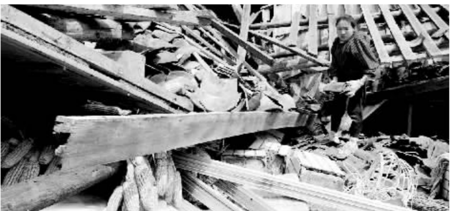
5月18日，彭州市龙门山镇一位受灾群众在清理废墟。龙门山镇地处山区，是彭州市受灾最重的乡镇，全镇房屋几乎全部倒塌。目前，一些受灾群众陆续返回家中生产自救。
