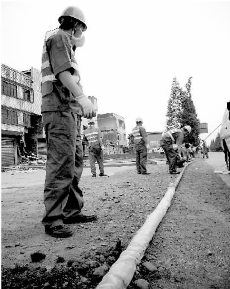
昨日, 郑州供水抢险队在灾区紧急抢修供水系统。
