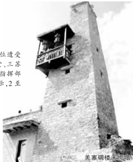
羌寨碉楼未垮塌
