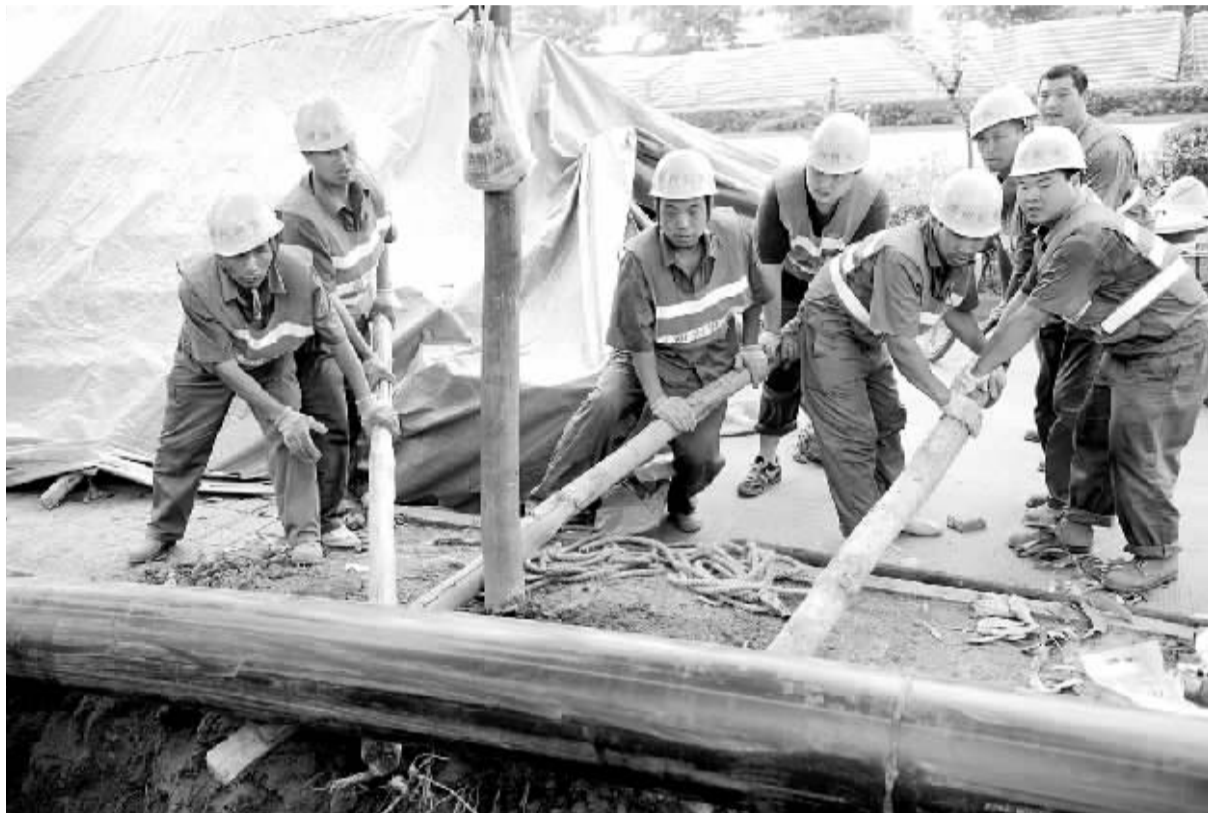
郑州市供水抢险救灾突击队正在紧张铺设自来水管
