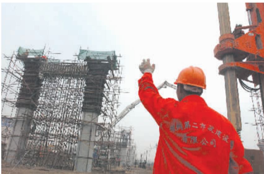
正在建设的南三环立交桥浇灌现场
