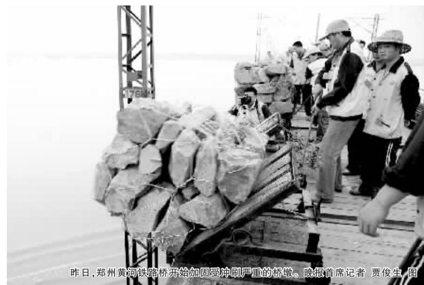
昨日，郑州黄河铁路桥开始加固受冲刷严重的桥墩。晚报首席记者 贾俊生 图
