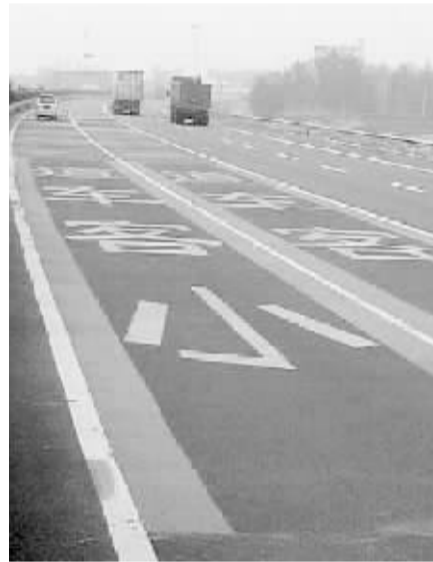
彩色小车专用车道,可以引导分流车辆,使司机集中精力,降低车速,确保安全。
