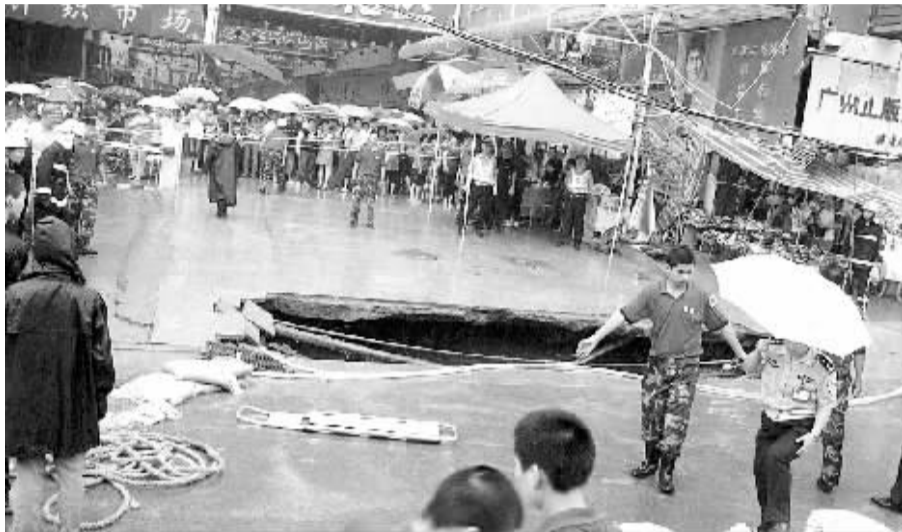
▲路面塌陷大坑,民警赶到现场维持秩序。
