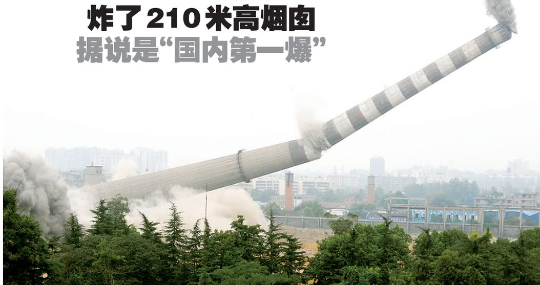
7月25日,210米高的烟囱轰然倒下。当日,成都华能电厂210米高的烟囱被成功实施爆破拆除。这是国内同类高度建筑爆破首例成功案例。据了解,此次爆破由成都、上海两地专家联合攻关两个月完成,堪称“国内第一爆”。这座烟囱重9300吨,塔底直径19.1米。据介绍,华能电厂建于1988年,于1990年投入运行。当时装机容量为20万千瓦,最高峰时每年为成都送电12亿度。但由于污染严重,该厂于2007年6月被关停,此后一直闲置。 新华社发
