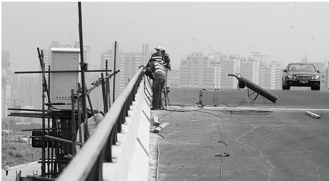
昨日下午,中州大道农业路立交桥二层,虽然已经通车,工人仍然在对桥不锈钢护栏做最后焊接。 晚报记者 周雨 图
