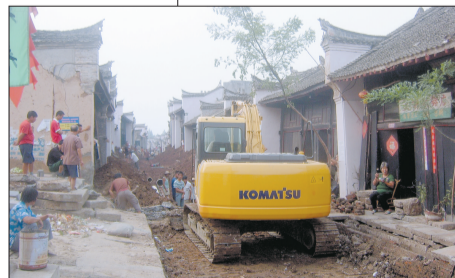
投巨资改造的清街雨水、污水和供水工程，正在紧张施工。
