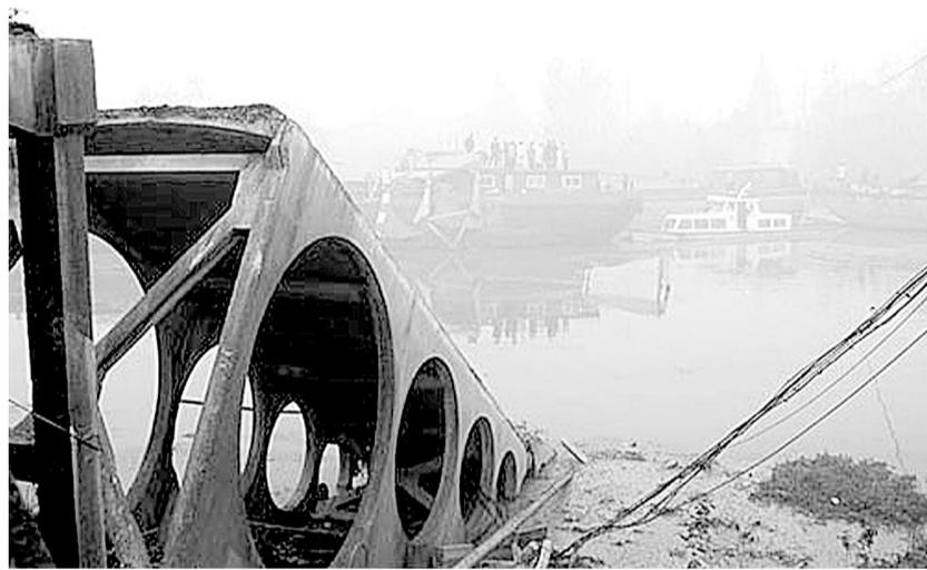
28日14时10分,一艘安徽籍空载货船和一艘来自江苏射阳的船只,同时经过江苏省高邮市汉留镇四异村境内的三阳河时,因为桥孔宽度有限,空载货船驾驶舱顶撞上四异大桥拱顶。长达130米的大桥瞬间被撞塌,断桥压住了两艘大船,两船内各有一名船员受伤。当地一位八旬老汉当时正在过桥,随着桥面一起坠下,堪称“奇迹”的是,老汉坠桥后并无大碍,因为情急中他一把抱住了桥上的栏杆,并随着栏杆一起坠落在船顶上,来了个“软着陆”。
